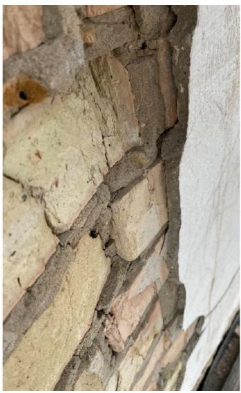
Banksy. Dettagli del distacco dell'intonaco dalla muratura
